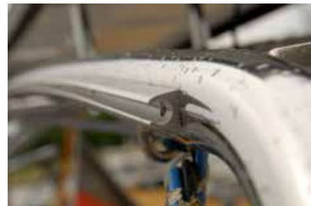
Die Keder-Aufnahmeschiene wurde mit dem Geräteträger verschraubt.
